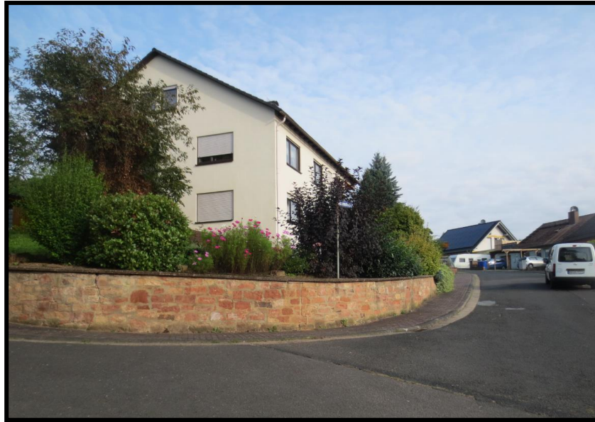
Gegenüberliegend die Einfahrt zur Gartenstraße mit Bebauung
