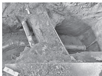
Abb.: Erneuerung eines Kanal – Hausanschlusses im öffentlichen Bereich
