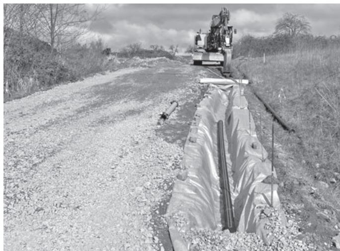
Abb.: Verlegung einer Drainage entlang der neuen Trasse
