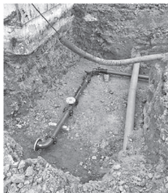
Abb.: Wasserleitungsarbeiten im Bereich der Freiwilligen Feuerwehr Schöllkrippen
