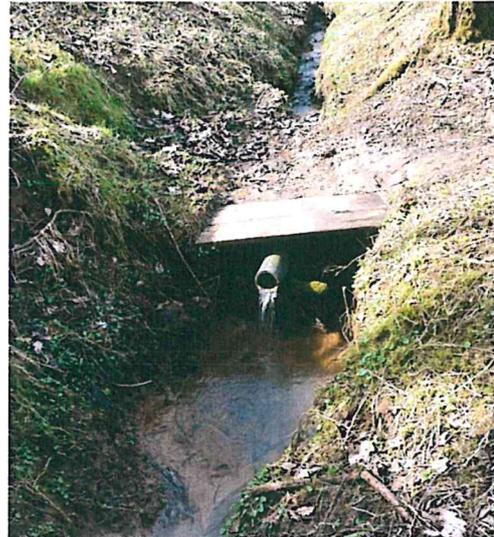
Graben mit punktueller Verrohrung und Erdverfüllung als Übergang
